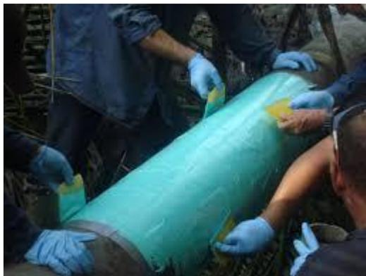
**Figura 8:** Aplicação do adesivo Syntho-Subsea<sup>TM</sup>LV Epoxy (retirado do site do fabricante)
